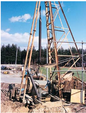
那須高原CSの井戸掘削作業
