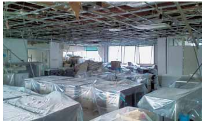
(本所 復旧工事状況)
